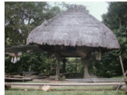
イフガオ地域の伝統的な高床式の家。床下での炊事の煙によって、竹や木がいぶされ、丈夫になり100年ほど住むことができるという <スタッフ撮影>
