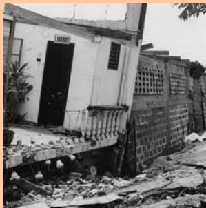
地震で崩れた建物
