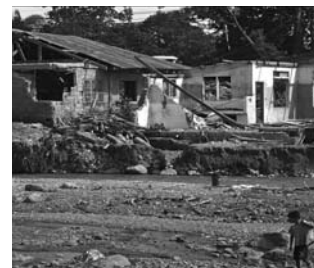
被災によって壊れた家々:2004年撮影
