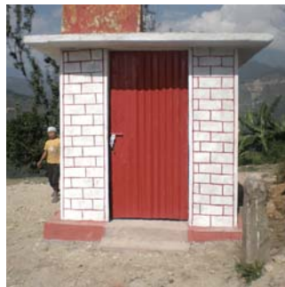
学校に完成したトイレ
