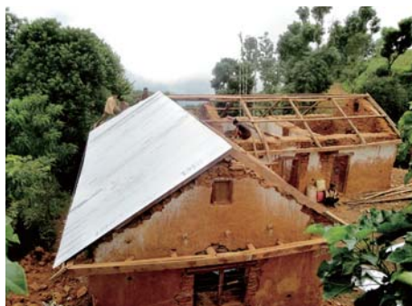
校舎の修復工事
