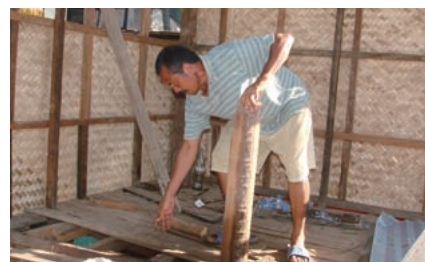
センターから支給された資材で家を修理するグレン・ローズのお父さん。
