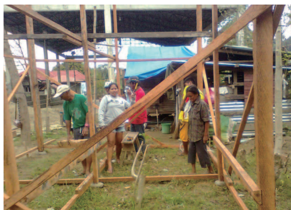
住宅再建の様子(イリガン市)。
