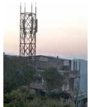
ランブール村にある電波塔
