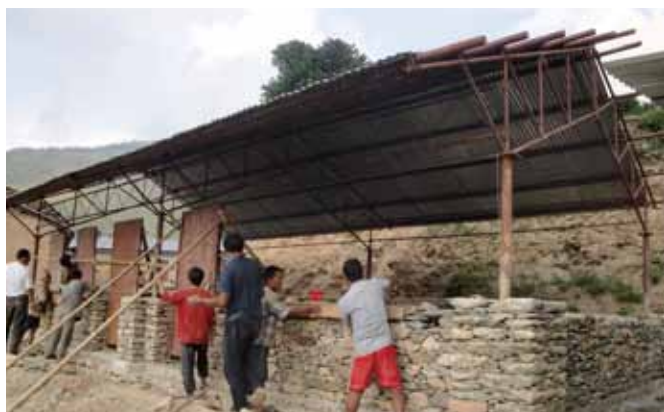
壁の石積みが進むセティデビ小学校
