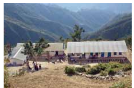
山間にあるブメタン小学校。右半分が今回の新築部分
