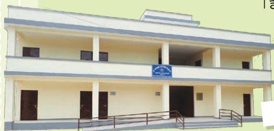
完成した校舎
