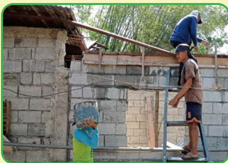
支給した資材を活用して家屋を再建
