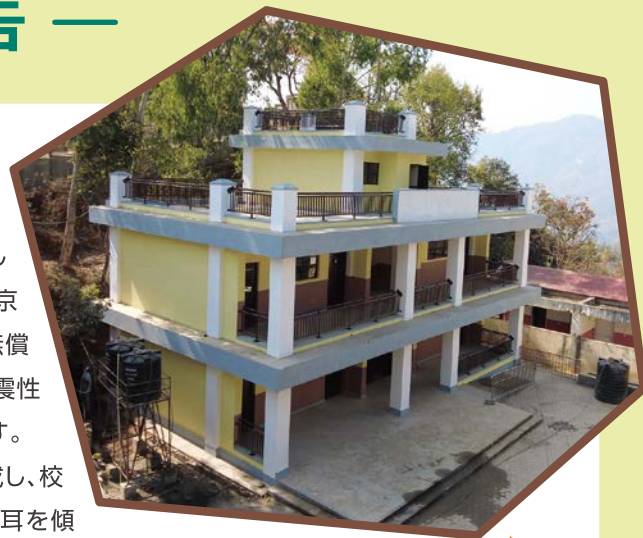
建設中の校舎
